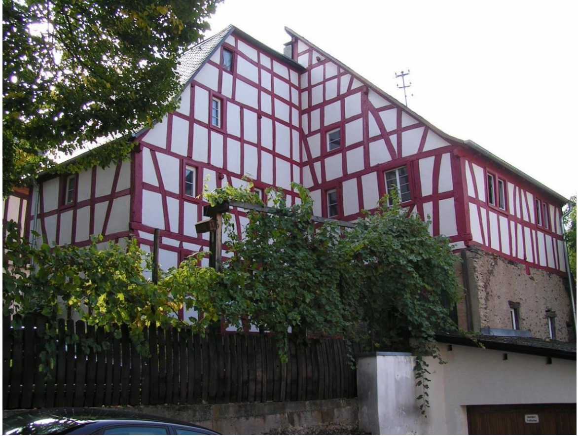
Abbildung 4 : Ansicht von der Kur - Trierer - Straße aus .
